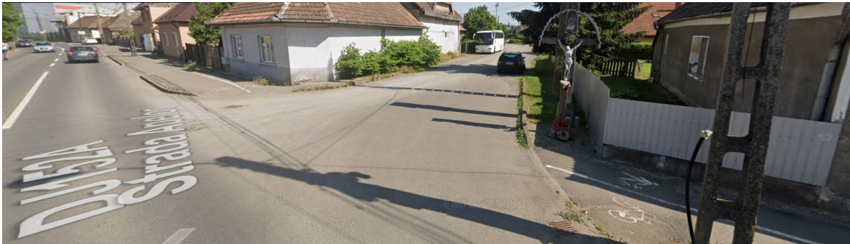
str. Podeni - Pista întreruptă - fără marcaje în intersecții
